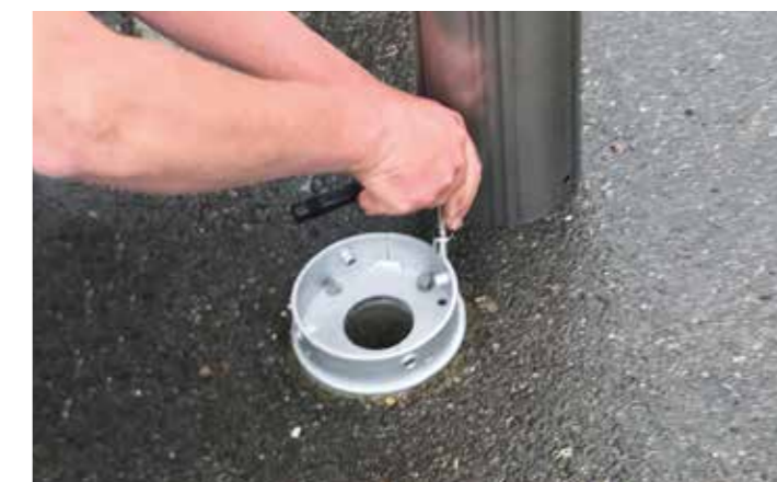
Installation facile avec le pieu ou le fourreau d'ancrage FERRADIX®, ici dans l'enrobé.
