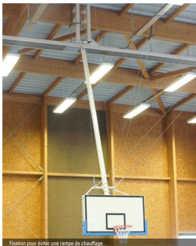
Fixation pour éviter une rampe de chauffage
