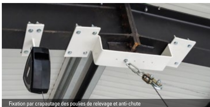
Fixation par crapautage des poulies de relevage et anti-chute
