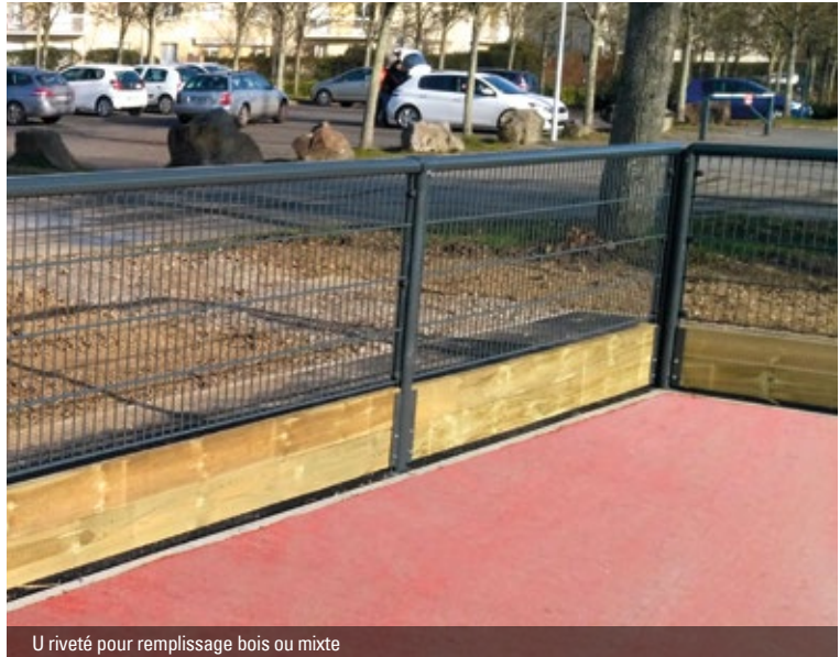
U riveté pour remplissage bois ou mixte
