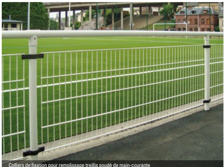
Colliers de fixation pour remplissage treillis soudé de main-courante
