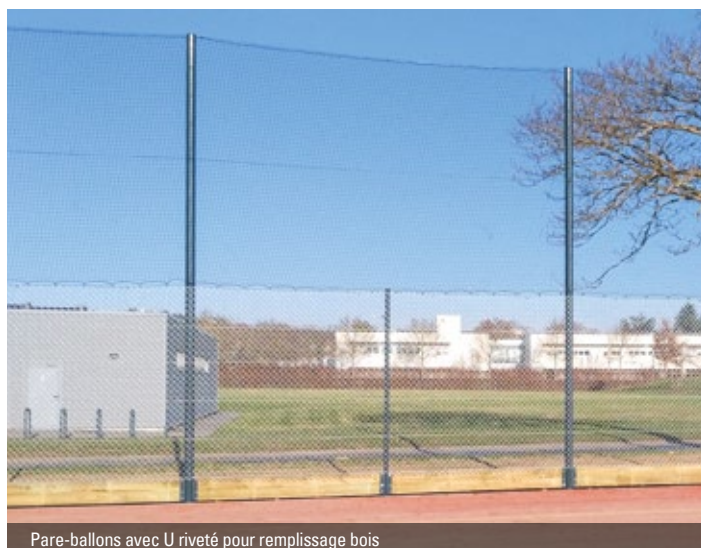
Pare-ballons avec U riveté pour remplissage bois
